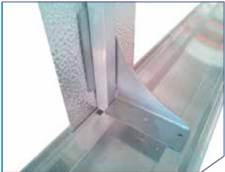
Montaje de la escuadra de refuerzo con el travesaño
